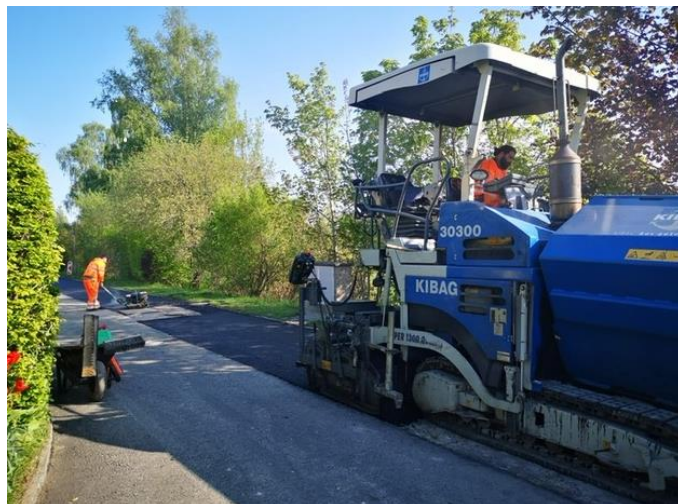
Es wird Asphalt eingebaut.
