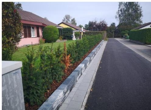
Der Belag (Tragschicht) in diesen Strassen ist bis Mitte Strasse ersetzt und eingebaut. Der Deckbelag wird nächsten Frühling/Sommer eingebaut. Für die zweite Strassenhälfte wird an der Gemeindeversammlung im Dezember ein Verpflichtungskredit für die Sanierung der Strasse beantragt.
