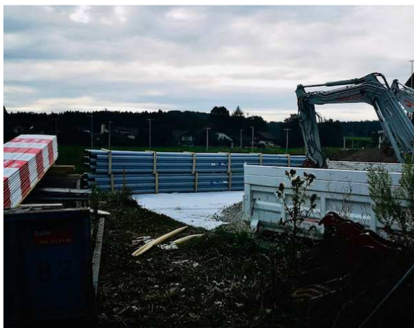
Die Bauarbeiten verlaufen im Terminprogramm.
